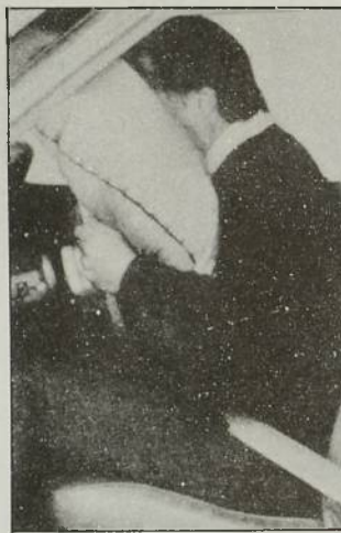
Ο αερόσακος δεν αφήνει το σώμα του οδηγού να κτυπήσει στο τιμόνι.
