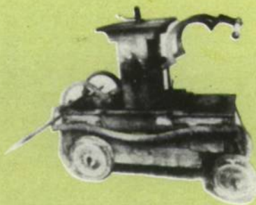
Χειροκίνητη πυροσβεστική αντλία Philips του 1766.
