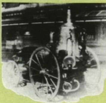
Ατμοκίνητη πυροσβεστική αντλία Merryweather του 1863 που χρησιμοποιήθηκε στην κατάσβεση της μεγάλης πυρκαϊάς των Ανακτόρων της 24 και 25 Δεκεμβρίου 1909 από το Λόχο Πυροσβεστών.
